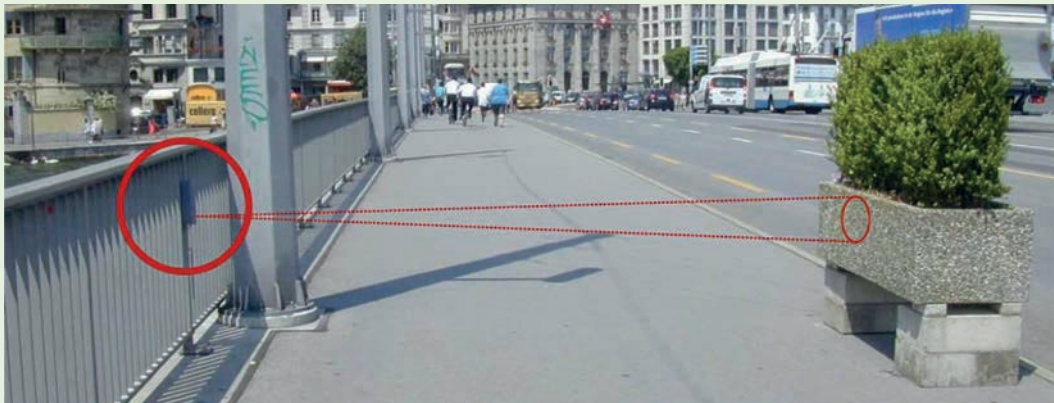
Figuur 9 – Voorbeeld van opstelling van een passief-infraroodsensor (bron: Stadt Luzern, 2012)
