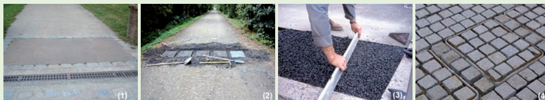
Figuur 17 – Teluitrusting met tegels in paden met een "zacht" wegdek (1) en (2), in grond onder een asfaltverharding (3) of in een bestrating (4) (bron: Eco-compteur, 4must.be)
