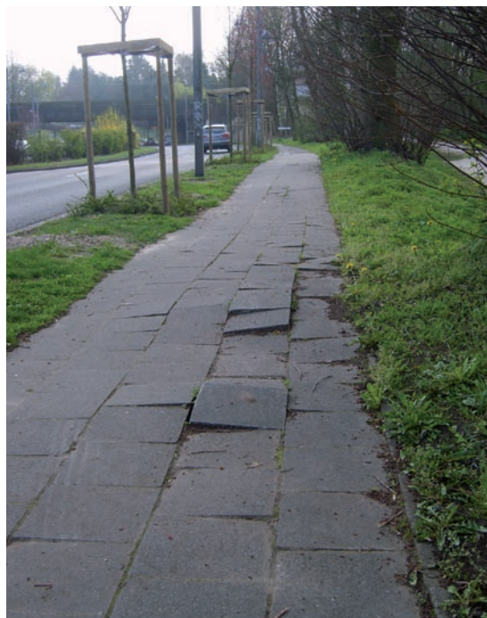
Tegerverhardingen zijn zeer gevoelig voor opstuwende boomwortels
