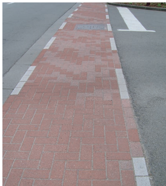
Fietsoversteek met een verharding van rode betonstraatstenen, aangevuld met wegmarkeringen van witte stenen
