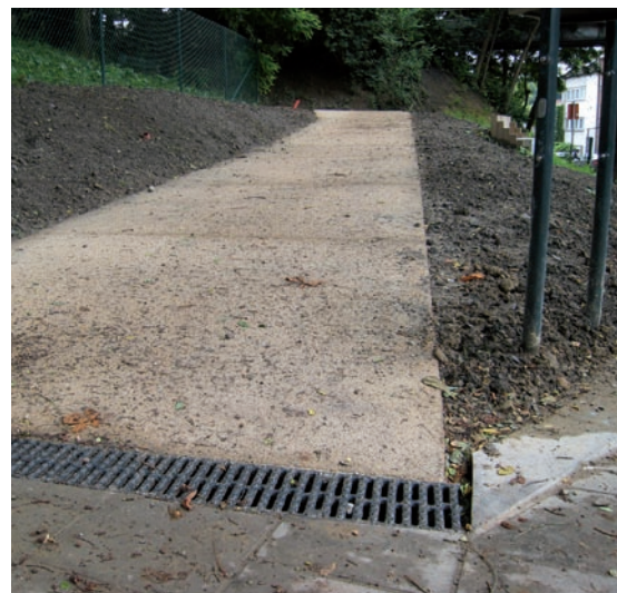
Verharding van uitgewassen beton voor de toeritten naar de spoorwegwandeling in Woluwe
