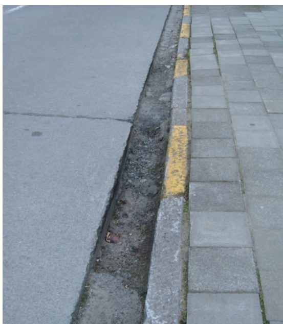
Bij een uitwijkmanoeuvre vormt deze weggoot een gevaar voor de fietser
