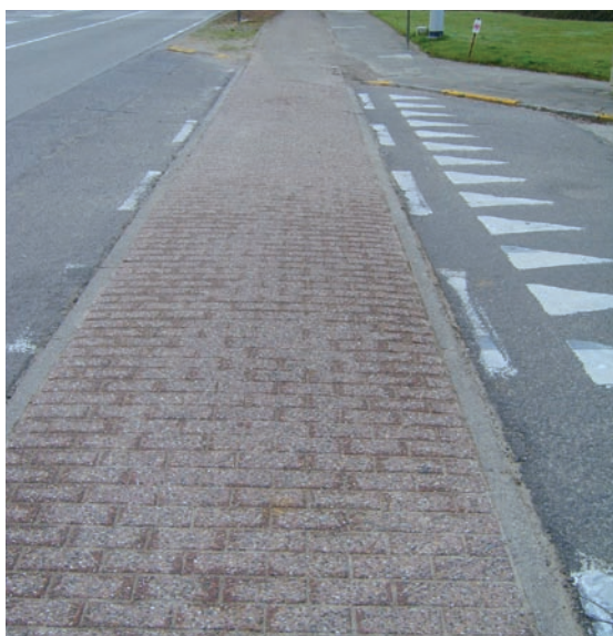
Doorlopend gebruik van betonstraatstenen op de fietsoversteek aan een zijstraat geeft de continuïteit van het fietstraject aan
