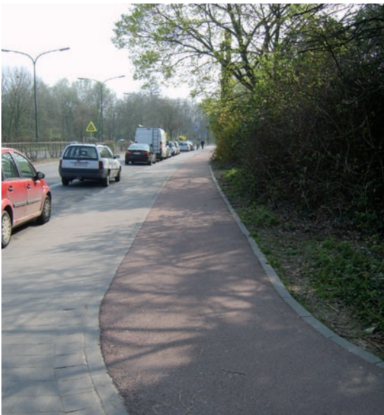
Voetgangers en fietsers delen de verkeersruimte. Het fietspad heeft een roodgekleurd verhardingsoppervlak
