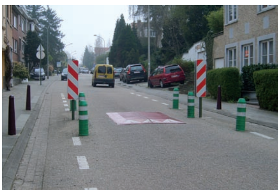
Wegversmalling met busdrempel in het midden en zijdelingse vrije doorgangen voor fietsers
