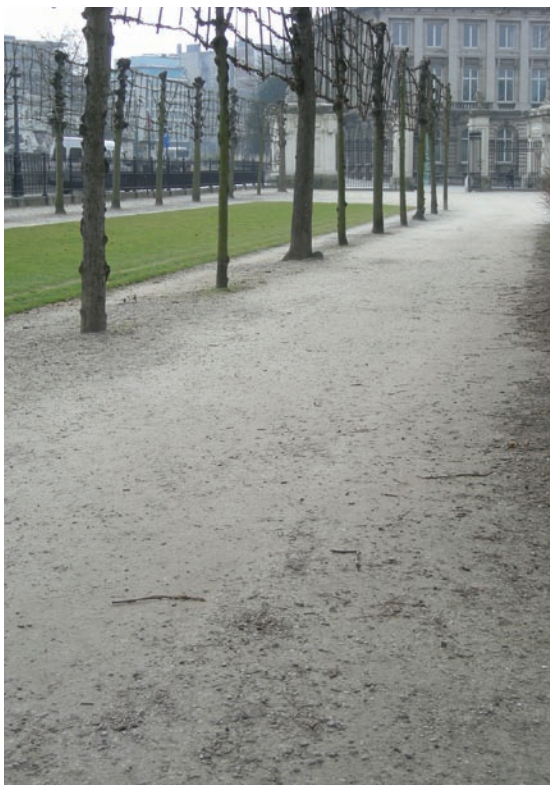
Dolomietverharding. Voor fietsvoorzieningen is het gebruik van dolomiet af te raden
