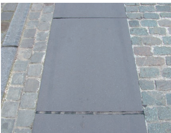
Comfortstroken van basaltbeton
