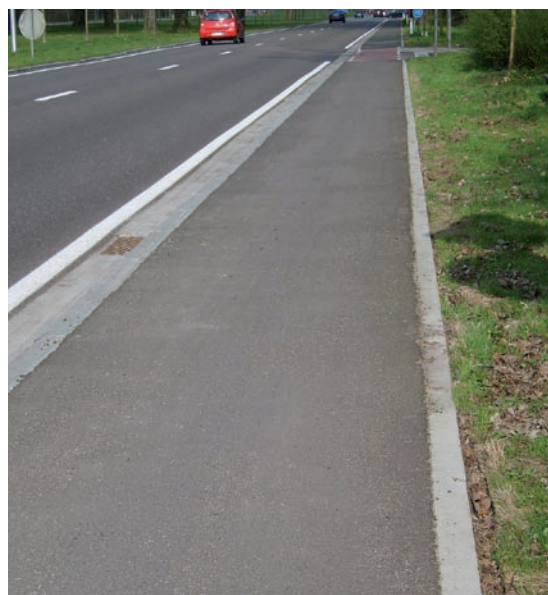
Vrijliggend fietspad van asfalt
