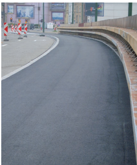
Dit pas aangebrachte fietspad van asfalt biedt een uitstekend rijcomfort
