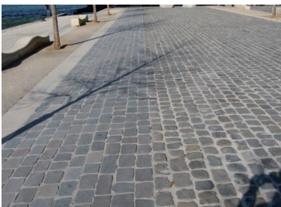
Verharding van klassieke straatkeien met een comfortstrook van gezaagde keien
