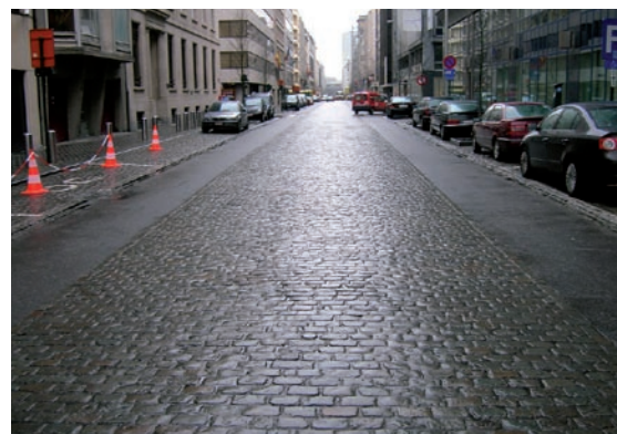
Comfortstroken van asfalt op een eigen fundering
