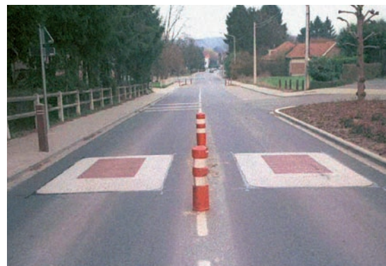
Zogenoemde busdrempels of verkeersdrempels met fietspassage
