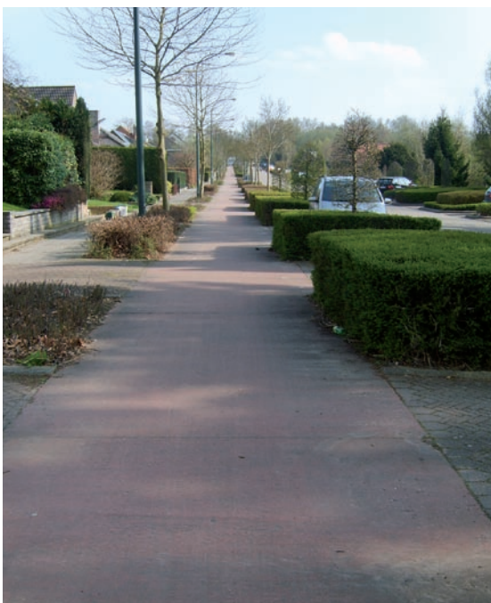
Vrijliggend fietspad van beton
