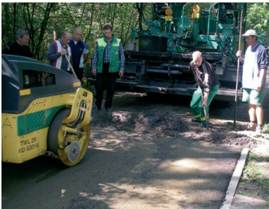
Verwerking van ecologisch asfalt
