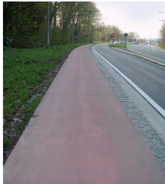
Vrijliggend fietspad van roodgekleurd beton
