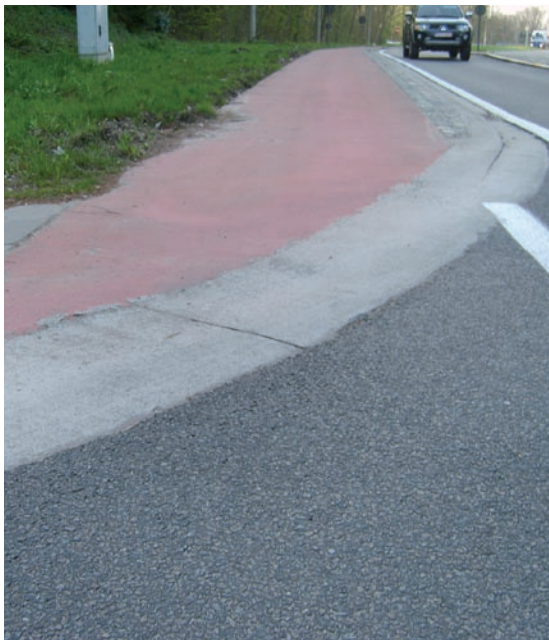
Vlakke overgang zonder goot of trottoirband
