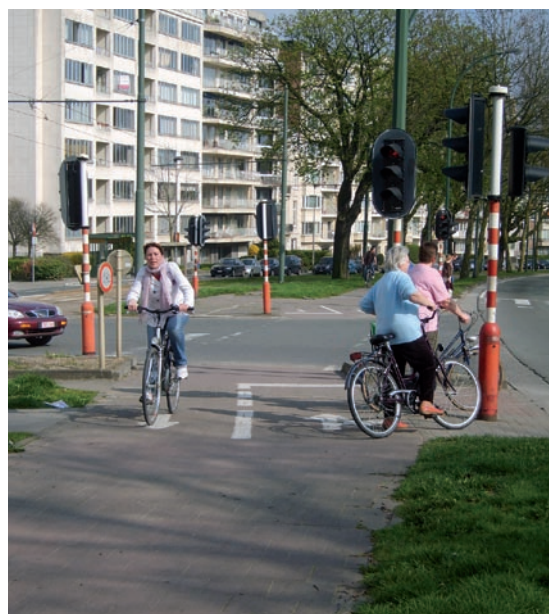
Vrijliggend tweerichtingsfietspad met een verharding van betontegels
