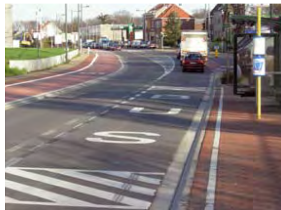
Figuur 3.1. – Veel mensen denken dat de schuine markeringen een verdrijvingsvlak vormen, waarover niet gereden mag worden. Deze markering, die in feite enkel een verkeersregel herhaalt, heeft als bijkomende nadelen dat het straatbeeld onnodig verzwaard wordt en dat de markering bij regenweer glad is voor al dan niet gemotoriseerde tweewielers. Bijgevolg bevelen wij aan deze markering niet meer toe te passen bij het halteren op de rijbaan en enkel het woord "BUS" te markeren om toch duidelijk te maken dat er op die plaats een bushalte is.
