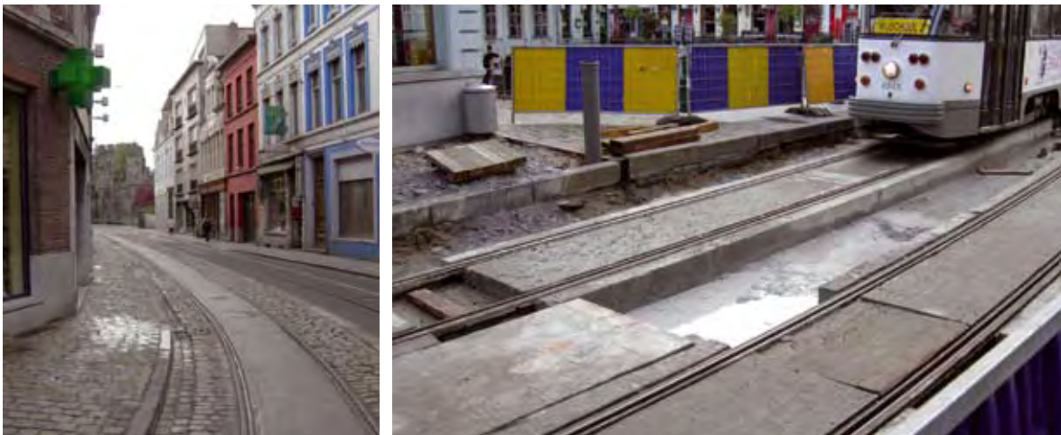
Figuur 4.1. en 4.2. – Tramsporen in combinatie met kasseien zijn een echte hel voor fietsers. Een mogelijke oplossing is om een comfortstrook tussen de tramsporen aan te leggen.
