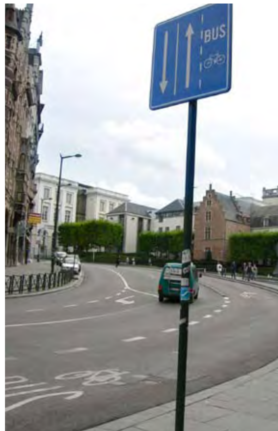
Figuur 5.3. – Ravensteinstraat: een gesloten profiel op een helling.
