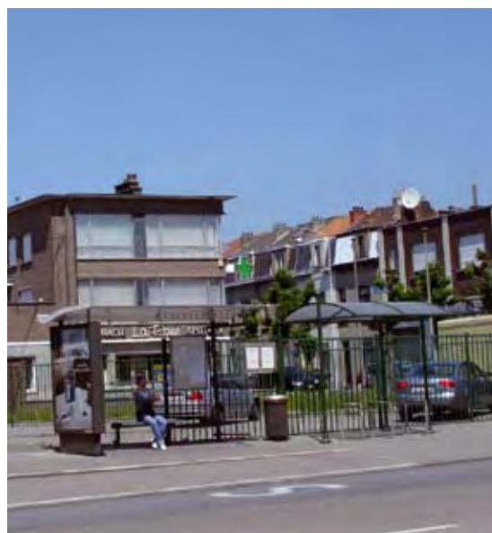
Figuur 2.4. – Bushalte met overdekte fietsenstalling. (Foto: Directie Infrastructuur Openbaar Vervoer.)
