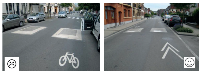
Figuur 8: Parkeren naast een rijbaankussen
