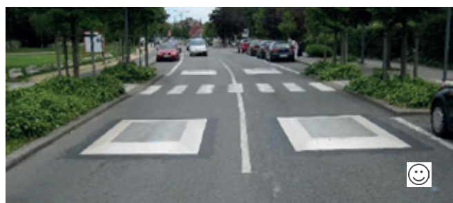
Figuur 7: Naast elkaar geplaatste rijbaankussens bij een zebraad op een rijbaan die tussen 6 m en 7,2 m breed is [OCW 2020_1]
