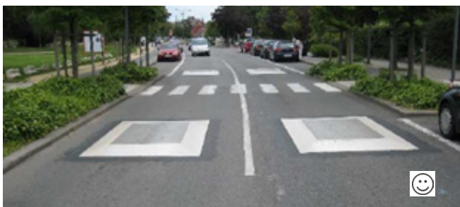
Figure 7 : Installation de coussins côte à côte à proximité d'un passage piéton sur une chaussée dont la largeur est comprise entre 6 m et 7,2 m [CRR 2020_1]
