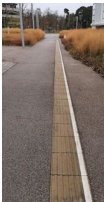
Ligne guide tactile et contrastée.
