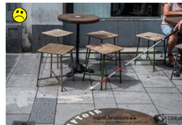
Ligne guide interrompue par la présence de mobilier.
