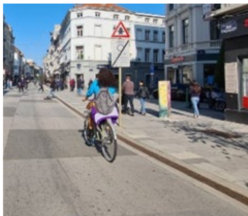
Filet d'eau pouvant faire office de ligne guide contrastée.
