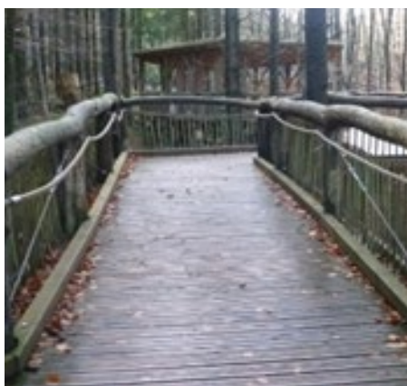
Bordure continue servant de ligne guide.
