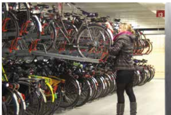
Grâce à l'utilisation de vérins pneumatiques, le poids à soulever ne constitue plus un obstacle pour les râteliers étagés.
