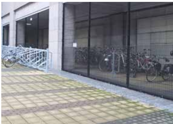
Gare du Nord: rack SNCB et parking à accès sécurisé.
