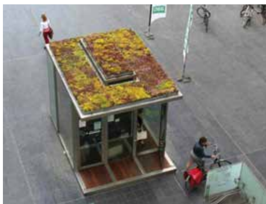
Remise à vélos recouverte d'une toiture végétale par grassroofcompany.co.uk .
