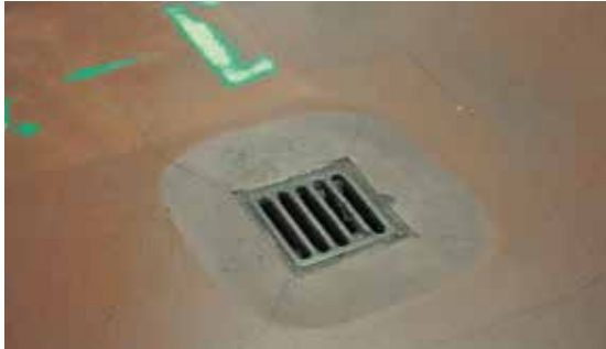
Puisard d'évacuation au point bas du parking.
