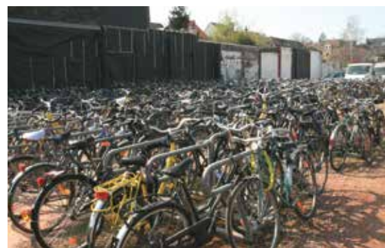
En haut, les arceaux sont installés sur une assise de bonne qualité. En bas, la dolomie n'est pas un bon support car par temps de pluie, le revêtement se détériore.
