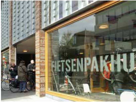
Le dépôt vélo de Zaandam, aménagé à l'attention des visiteurs des magasins du centre urbain.
