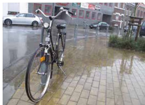
Élégante installation anti-stationnement aménagée à Woluwe-Saint-Lambert, qui offre simultanément la possibilité d'y accrocher des vélos. Malheureusement, ce système n'est pas recommandable. Le vélo n'est soutenu qu'en un seul point de sorte qu'il peut rapidement tomber à défaut d'autre support. À une distance aussi courte de la chaussée, ce n'est certainement pas l'idéal.
