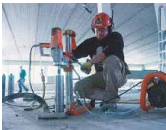
Forage d'orifices à l'aide d'une mèche diamant refroidie à l'eau et montée sur un trépied.
