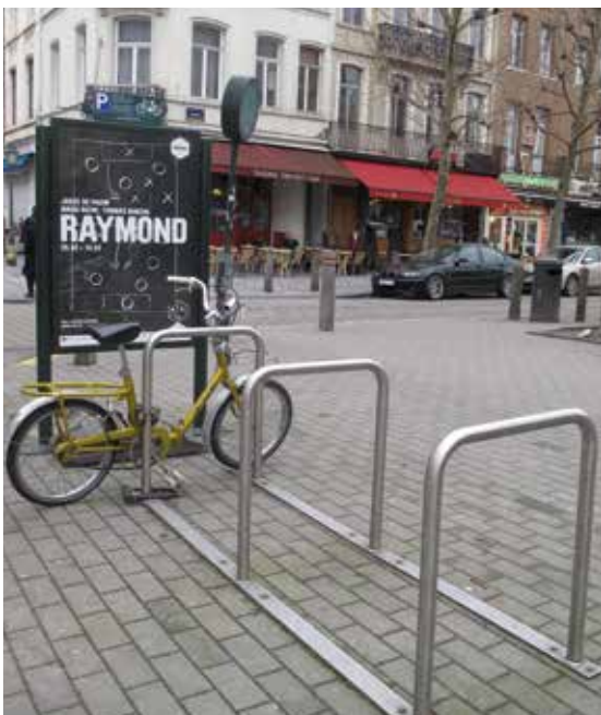
La place Jourdan est équipée d'un râtelier composé d'arceaux en U fabriqués en inox. Chaque arceau est fixé à l'aide de quatre vis.
