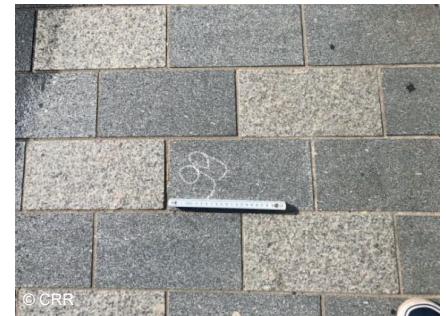
Pavés de granite sciés et flammés placés sur la place du Miroir (Jette) offrant une très bonne qualité d'usage (confort = 10/10, adhérence (PFT) = 0,69)
