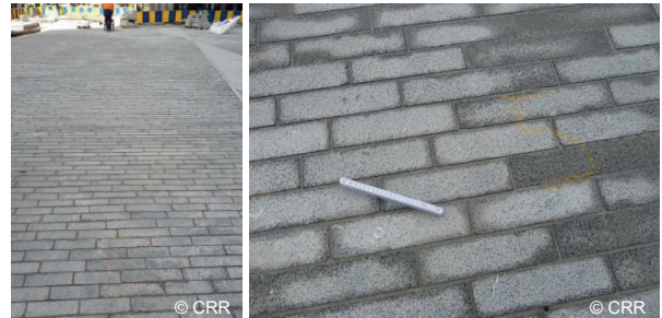
Pavés sciés en pierre bleue bouchardée placés sur le piétonnier de Bruxelles et offrant une très bonne qualité d'usage (confort = 9,5/10, adhérence (PFT) = 0,85)
