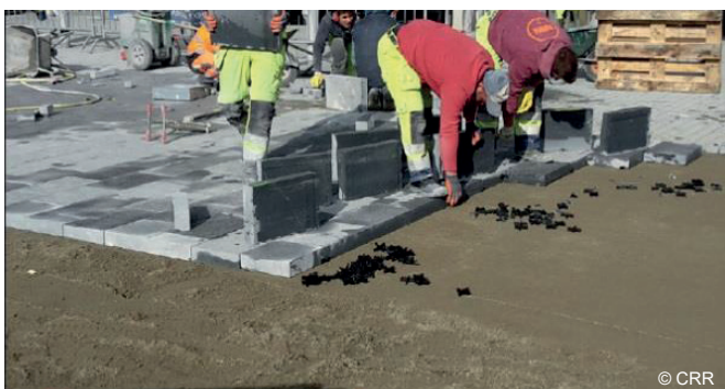
Profilage et égalisation du lit de mortier pour dalles en pierre naturelle
