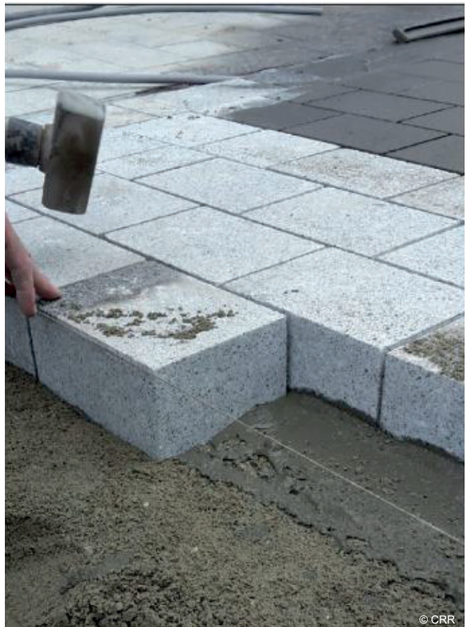
Mise en oeuvre de pavés en pierre naturelle avec application d'une couche d'adhérence entre la couche de pose et le pavé
