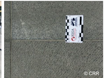
Dalles de pierres bleues avec finition de surface placées à proximité de la gare du Nord et présentant une très bonne qualité d'usage (confort = 10, adhérence (PFT) = 0,77)
