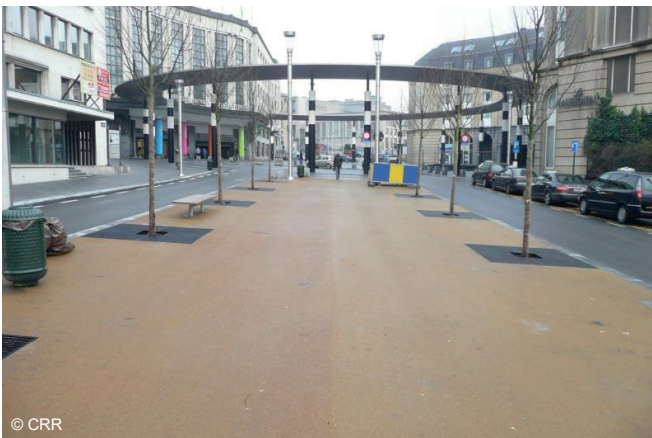
Revêtements piétons continus en asphalte coloré (ci-dessus - Boulevard de l'Impératrice) et en béton continu (ci-dessous - Quai à la Houille) offrant une excellente qualité d'usage piétons.
