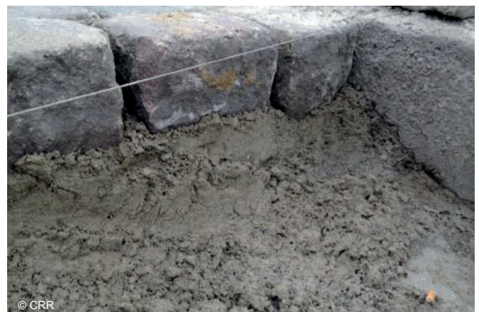
Couche de pose en sable ciment
