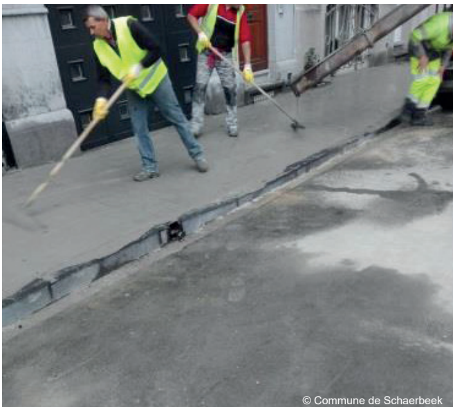
Remplissage des joints au mortier modifié à Schaerbeek (rue Pelletier)
