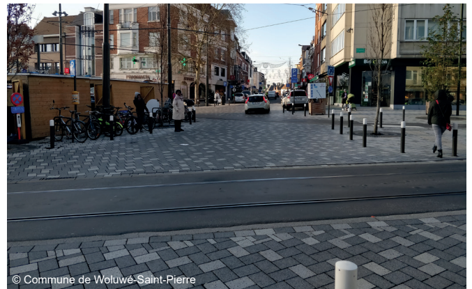
Place Dumon (Woluwe-St-Pierre) : revêtements piétons en pavés de béton coloré offrant une bonne qualité d'usage
