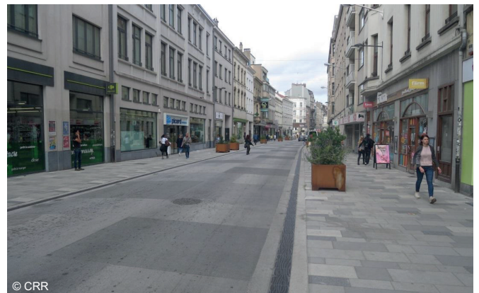
Chaussée d'Ixelles (Ixelles) : revêtements piétons en dalles de béton coloré offrant une très bonne qualité d'usage
