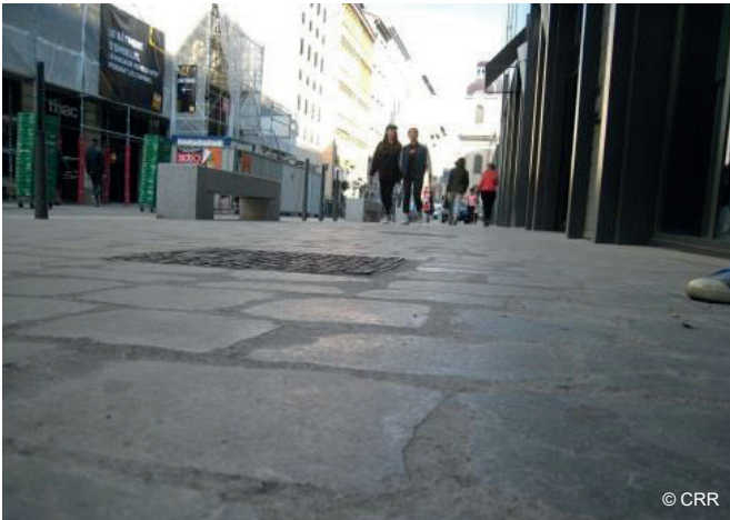
Revêtement piéton en pierre naturelle présentant une surface plane et des joints non creusés à Lyon
