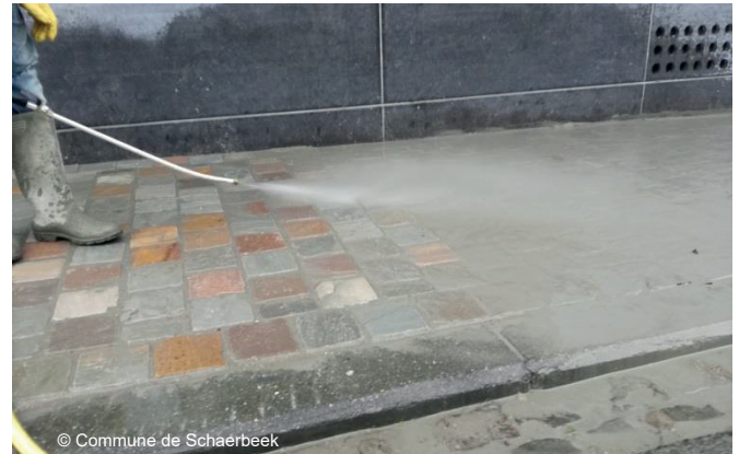
Nettoyage du pavage à l'aide d'un diffuseur de jet permettant d'envoyer l'eau presque parallèlement à la surface du pavage (source : administration communale de Schaerbeek)
