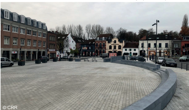
Place St Lambert (Woluwe-Saint-Lambert) : revêtements piétons en granite offrant une très bonne qualité d'usage
