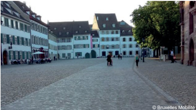
Traitement d'irrégularités de surface : (ci-dessus) bande de confort en pavés sciés sur une chaussée en pavés classiques à Bâle; (ci-dessous) revêtement en béton à Lyon, poncé après placement à la demande des usagers pour supprimer les irrégularités et l'inconfort ressenti
