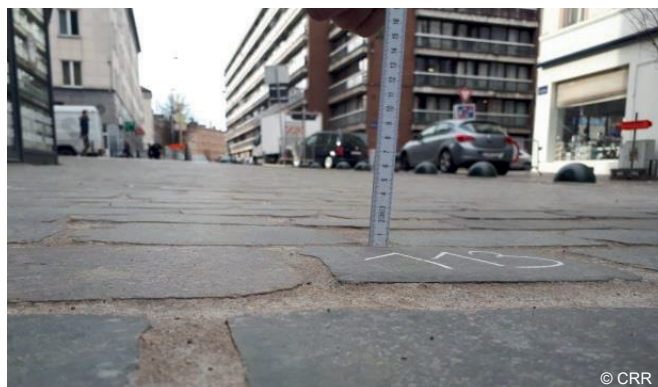
Pavés porphyres sciés présentant une surface identique mais un confort différent (place communale de Molenbeek ci-dessus : joints creusés de +/- 54 mm, confort = 5,6/10. Ci-après : joints creusés de +/- 1 mm, confort = 7,5/10)
