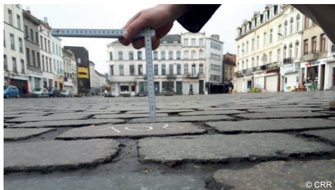
Pavés porphyres sciés présentant une surface identique mais un confort différent (place communale de Molenbeek ci-dessus : joints creusés de +/- 54 mm, confort = 5,6/10. Ci-après : joints creusés de +/- 1 mm, confort = 7,5/10)
