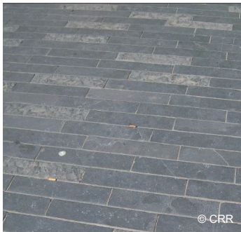
Revêtements alternants de la pierre naturelle polie et brute (à gauche). Au regard des surfaces polies existantes, le risque de glissade devrait être plus élevé à gauche que ci-dessous, où les pierres polies sont moins nombreuses et en alternance avec du granite
