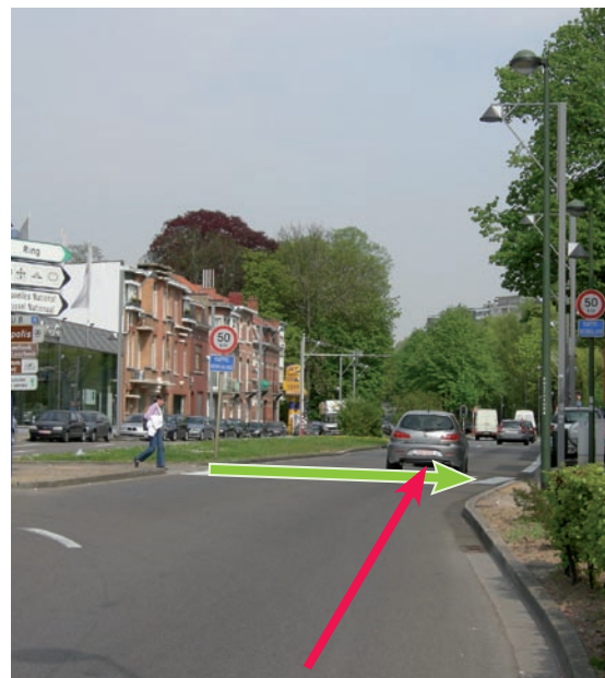
Figure 63 – Place de l'ancienne Barrière. Les entrées et sorties du rond-point, ovale, sont à 2 bandes et la très faible inflexion n'incite pas au ralentissement. Le piéton a été fauché alors qu'il avait franchi les 3/4 de la traversée (JET).
