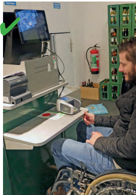
☺ De kassa heeft een gedeelte dat tot 80 cm van de grond is verlaagd, waardoor iedereen zonder problemen een transactie kan uitvoeren.
